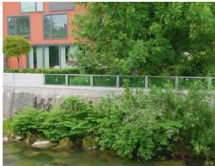
Hochwasserschutzwand mit Sicherheitsglas
