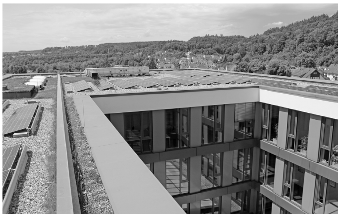
PV-Anlage auf dem Dach des Erweiterungsbaus des Landratsamtes.
